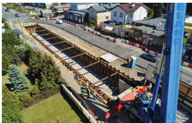
Budowa zbiornika retencyjnego w ciągu ul. św. Maksymiliana Kolbego
