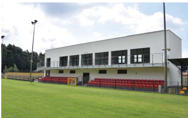
Nowo wybudowany budynek klubowy GKS LZS Wiekulec
