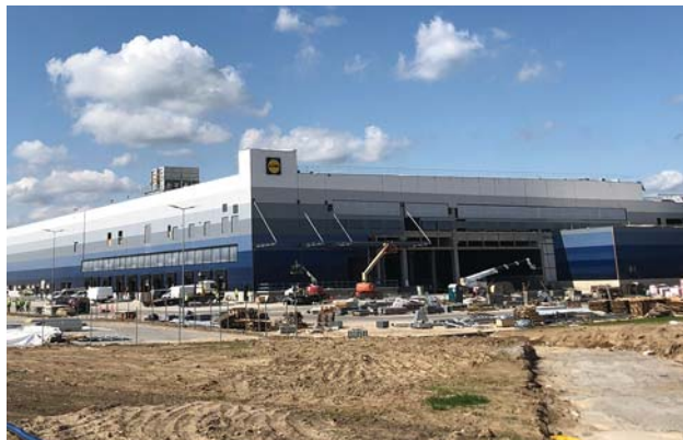
Montaż instalacji elektrycznych niskoprądowych oraz automatyki w Centrum Dystrybucji Lidl
