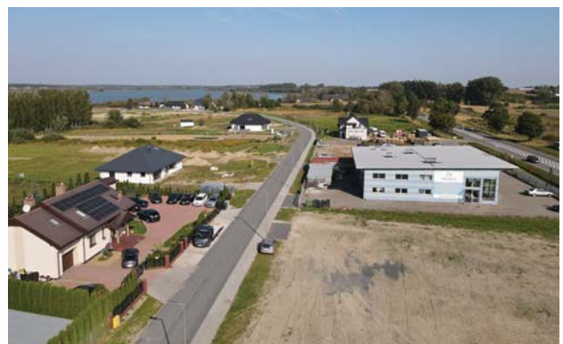
Przebudowana ul. Księżycowa w Nowej Wsi
