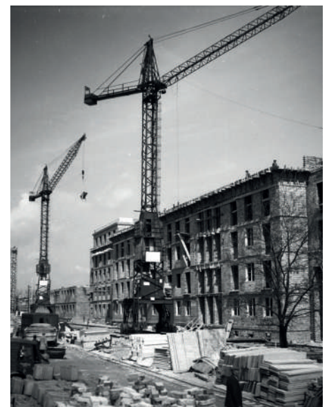
Osiedle Bielany 1. Budowa bloków przy ulicy Kasprowicz. Fot: Zbyszko Siemaszko/NAC
