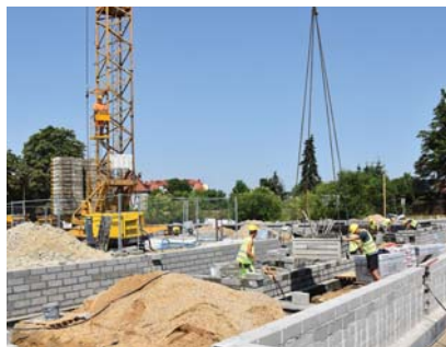
Trwa budowa warsztatów edukacyjnych – to jedna z największych inwestycji powiatu oławskiego w ostatnich latach
